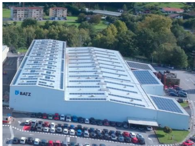
Instalaciones fotovoltaicas Planta BATZ Igorre
